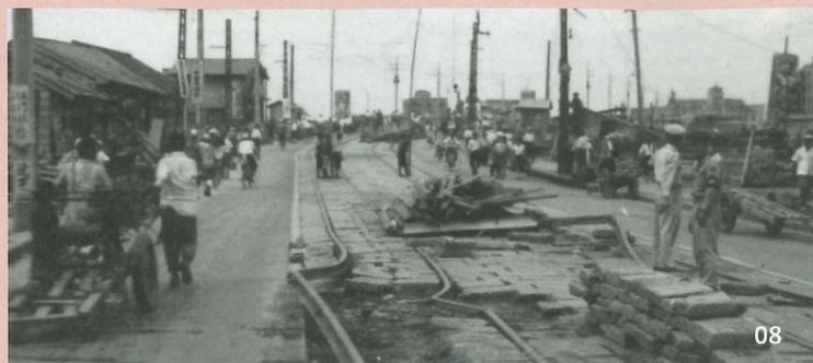
08 大きくゆがみ、めくれ上がった線路。国鉄、京福電気鉄道、福井鉄道のいずれもが、線路の沈下や湾曲、橋梁の損壊、列車の脱線、駅舎の倒壊などの大きな被害を受けた
