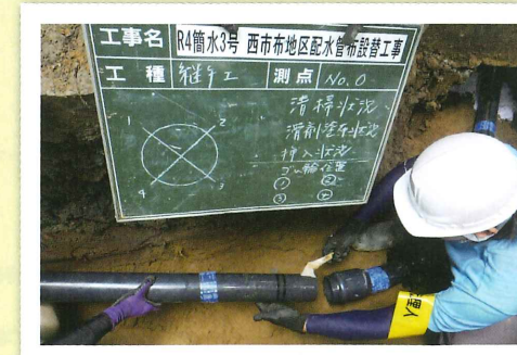
水道管更新の様子
