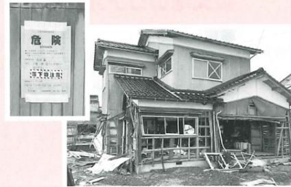
旧耐震基準と思われる家屋の例。1階部分は完全に倒壊しており、的被害が想定される
